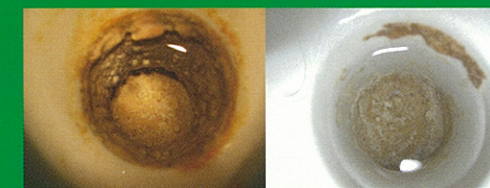
トイレ対策・悪臭対策
