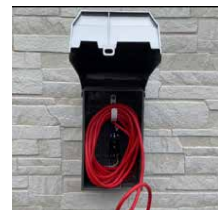
屋外カーポートにコードボックスを設置
