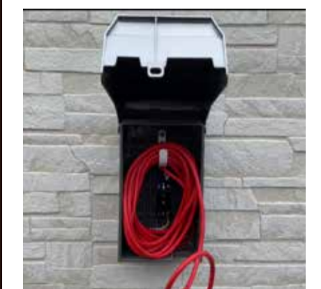
屋外カーポートにコードボックスを設置
