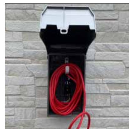
屋外カーポートにコードボックスを設置
